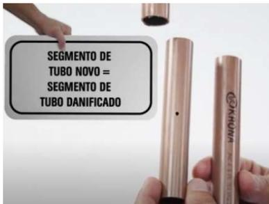
Identifique o ponto, drene a tubulação e abra a região para a manutenção. Corte de forma perpendicular e central o trecho danificado. Tal abertura deve possuir um comprimento maior que duas luvas de correr.
