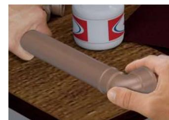
Encaixe as superfícies a serem soldadas posicionando o tubo até o fundo da bolsa. Atente-se para o correto posicionamento da peça.
