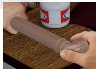
Encaixe as superfícies a serem soldadas posicionando o tubo até o fundo da bolsa. Atente-se para o correto posicionamento da peça.
