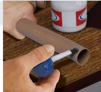
Limpe as superfícies lixadas utilizando a Solução Preparadora Krona. Com um pincel, passe o Adesivo Plástico Krona nas superfícies a serem soldadas, evitando o excesso de adesivo.
