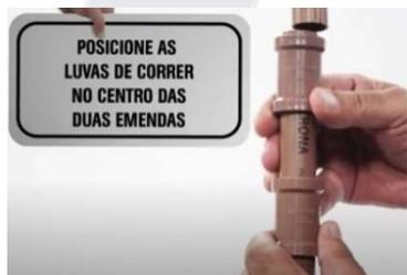
Com as luvas já montadas, alinhe este segmento com o tubo já instalado e deslize as duas luvas de correr sobre o tubo embutido. Posicione a luva no centro da emenda.
