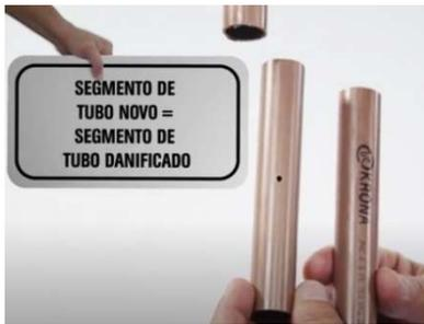
Identifique o ponto, drene a tubulação e abra a região para a manutenção. Corte de forma perpendicular e central o trecho danificado. Tal abertura deve possuir um comprimento maior que duas luvas de correr.
