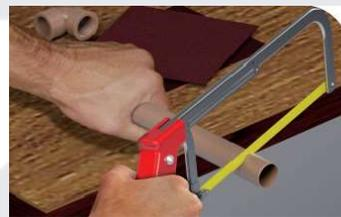
Corte o tubo no esquadro e lixe as superfícies a serem soldadas (ponta do tubo e bolsa da conexão) de forma a aumentar a aderência.
