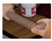
Encaixe as superfícies a serem soldadas posicionando o tubo até o fundo da bolsa. Atente-se para o correto posicionamento da peça.
