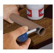
Limpe as superfícies lixadas utilizando a Solução Preparadora Krona. Com um pincel, passe o Adesivo Plástico Krona nas superfícies a serem soldadas, evitando o excesso de adesivo.
