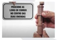
Com as luvas já montadas, alinhe este segmento com o tubo já instalado e deslize as duas luvas de correr sobre o tubo embutido. Posicione a luva no centro da emenda.
