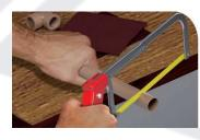
Corte o tubo no esquadro e lixe as superfícies a serem soldadas (ponta do tubo e bolsa da conexão) de forma a aumentar a aderência.
