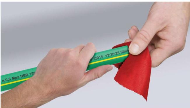
Limpe a ponta do tubo e o interior da conexão antes de efetuar cada termofusão.
