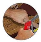
Cortar o tubo no esquadro e lixar as superficies a serem soldadas (ponta do tubo e bolsa do Registro) para aumentar a aderência. Após, utilizando solução limpadora limpe as superfícies lixadas para eliminar impurezas e oleosidade.
