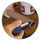
Aplique o adesivo na bolsa do Registro e após no tubo e encaixe os dois dando um giro de 1/4 de volta para uniformizar o adesivo na junta. Remova o exesso de ade-
