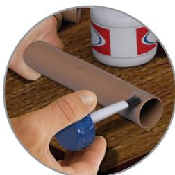
Aplique o adesivo na bolsa do Registro e, após, no tubo e encaixe os dois dando um giro de 1/4 de volta para uniformizar o adesivo na junta. Remova o excesso de adesivo. A tubulação pode ser pressurizada apenas 12 horas após esta soldagem.
