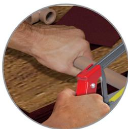
Cortar o tubo no esquadro e lixar as superfícies a serem soldadas (ponta do tubo e bolsa do Registro) para aumentar a aderência. Após, utilizando solução limpadora, limpe as superfícies lixadas para eliminar impurezas e oleosidade.
