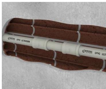
Com as luvas já montadas, alinhe este segmento com o tubo já instalado e deslize as duas luvas de correr sobre o tubo embutido. Posicione a luva no centro da emenda.
