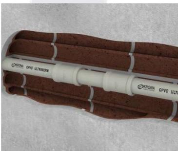
Com as luvas já montadas, alinhe este segmento com o tubo já instalado e deslize as duas luvas de correr sobre o tubo embutido. Posicione a luva no centro da emenda.
