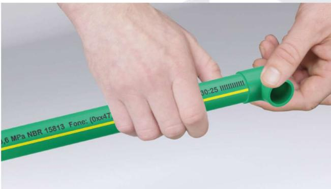
Alinhe a conexão ao tubo durante os primeiros 5 segundos após a termofusão. Caso haja necessidade, após realizar o encaixe, alinhe a conexão em um intervalo de aproximadamente 4 segundos alinhe a conexão em até 15°.
