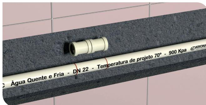
**4º Passo:** Eliminar as rebarbas e fazer um pequeno chanfro nas extremidades cortadas do tubo que ficarem na parede. Limpe estas extremidades, utilizando pano limpo ou estopa.
